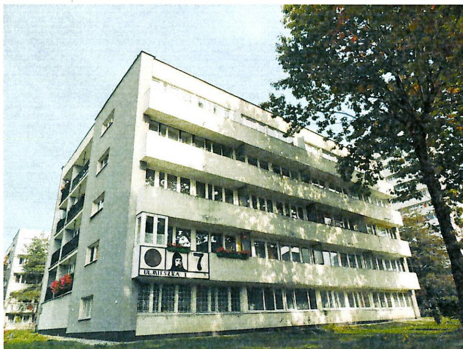
Fot. 1. Widok elewacji południowej.
