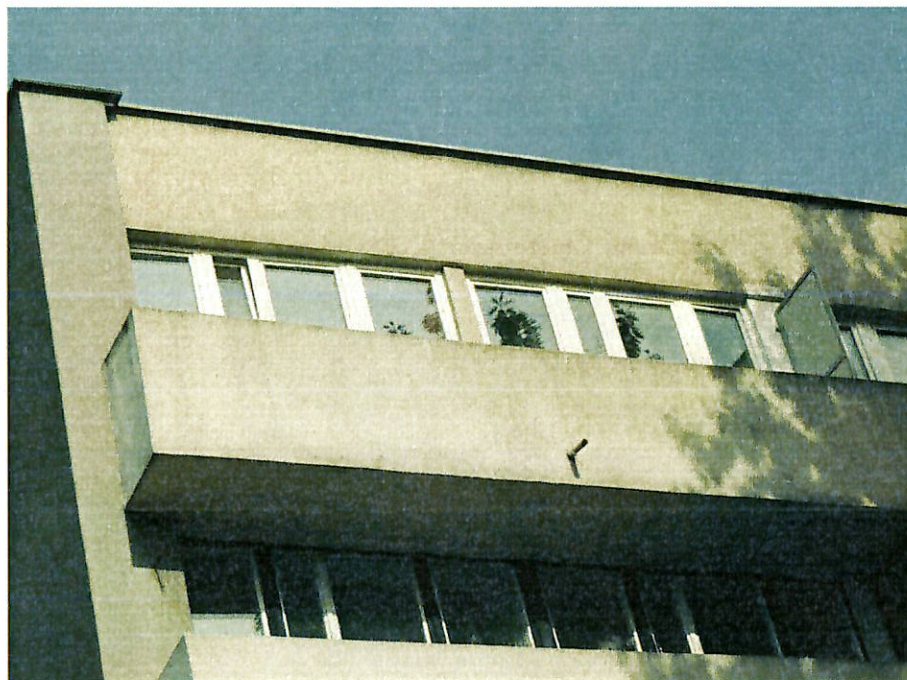
Fot. 2. Widok fragmentu elewacji południowej. Widoczne balkony ostatniej kondygnacji.
