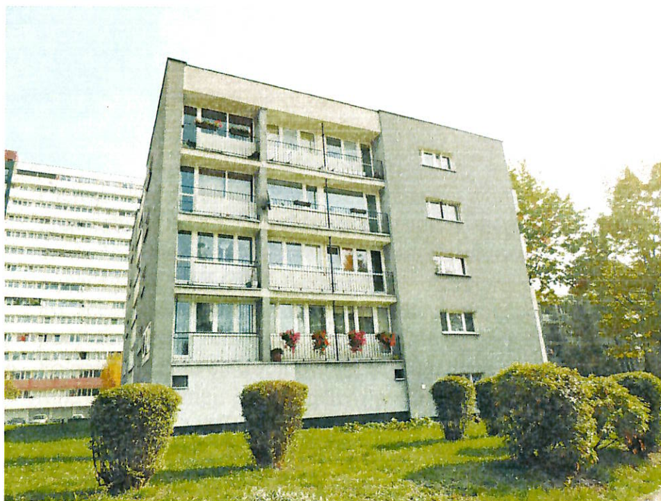
Fot. 5. Widok elewacji zachodniej.
